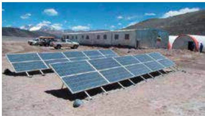
Proyecto Energia Solar - Campamen- to Minera Las Bambas - Cuzco
